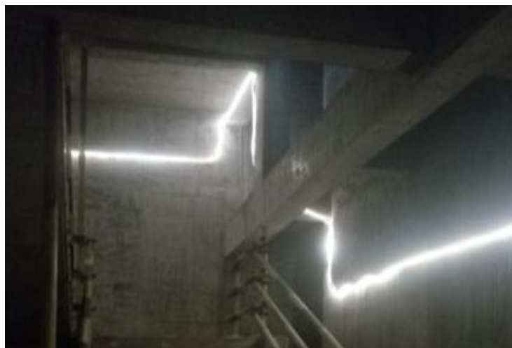
楼层照明示例
