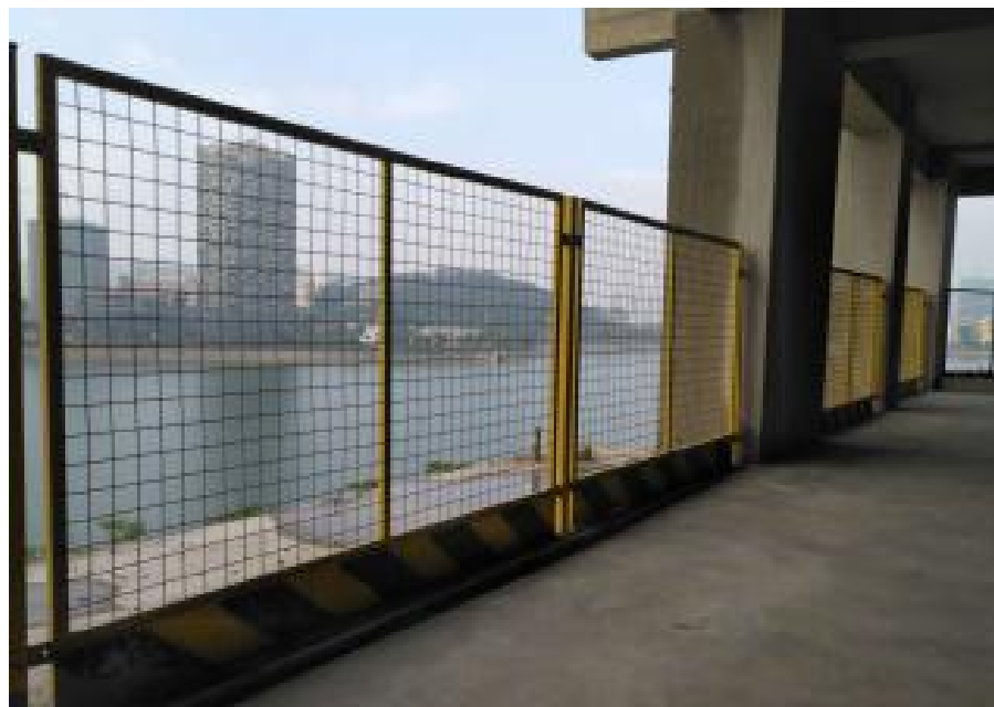
楼层临边防护现场图示2
