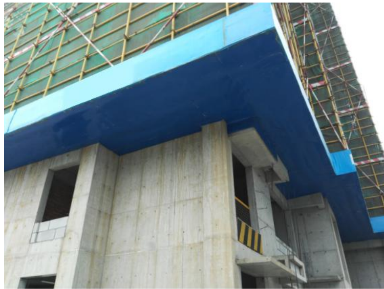
挑梁底部封闭构造图示
