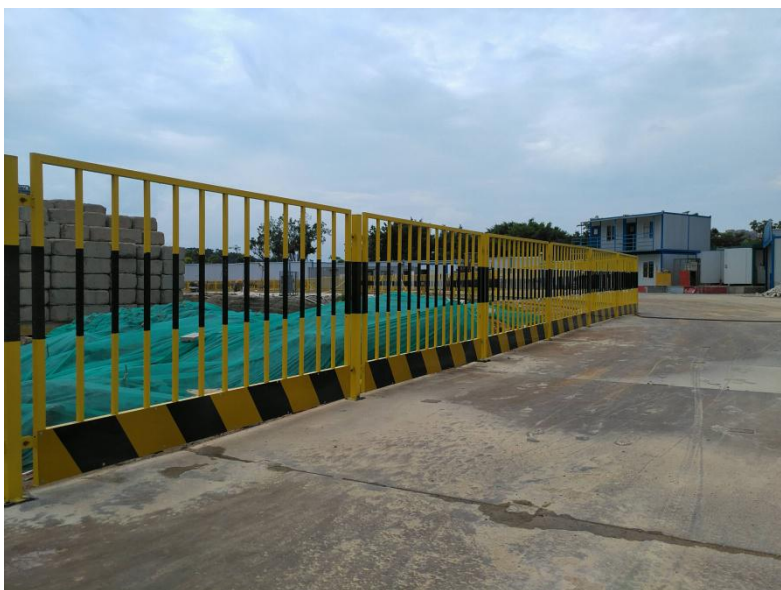
基坑定型化防护大样
