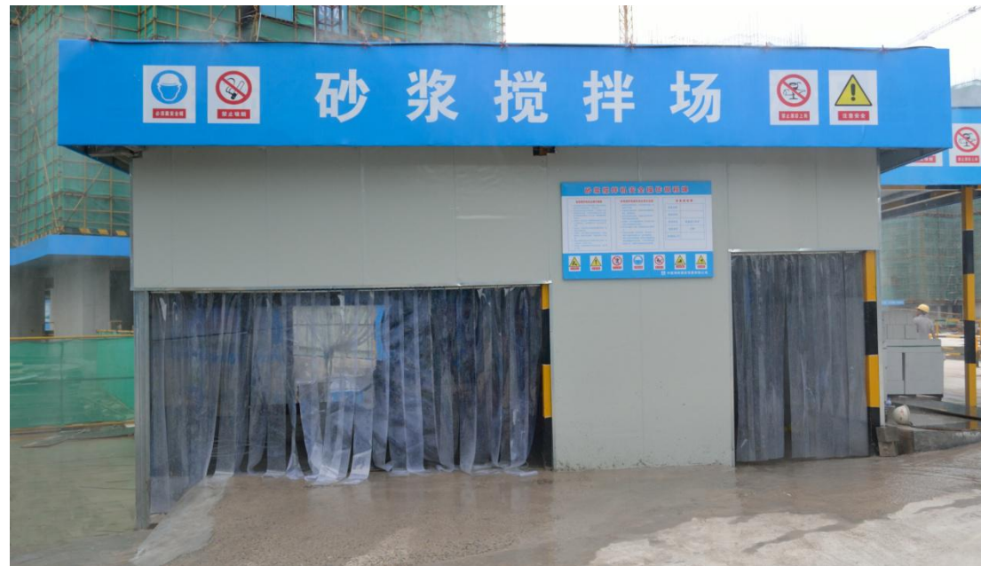
封闭式搅拌防护棚
