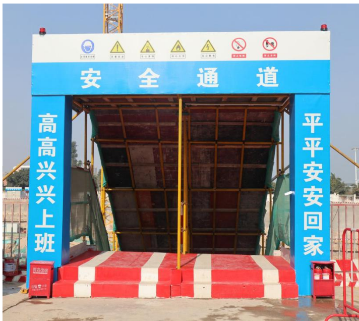
基坑放坡式安全通道示例
