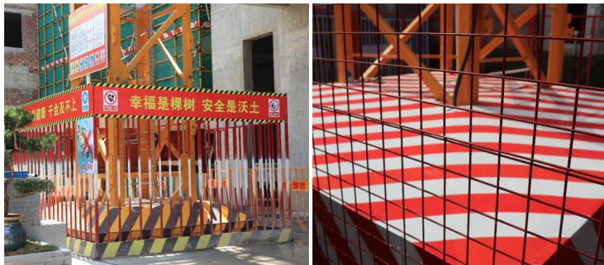
塔吊基础防护、顶板隔断图示
