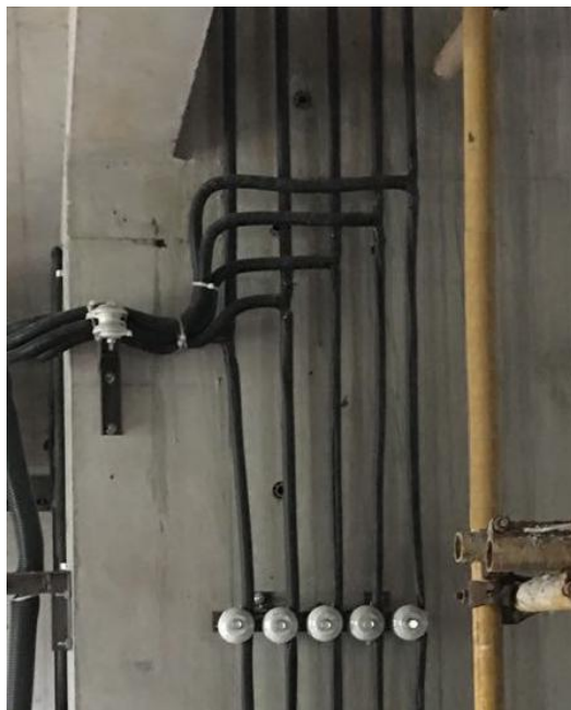
电缆线瓷瓶绝缘子挂设图示
