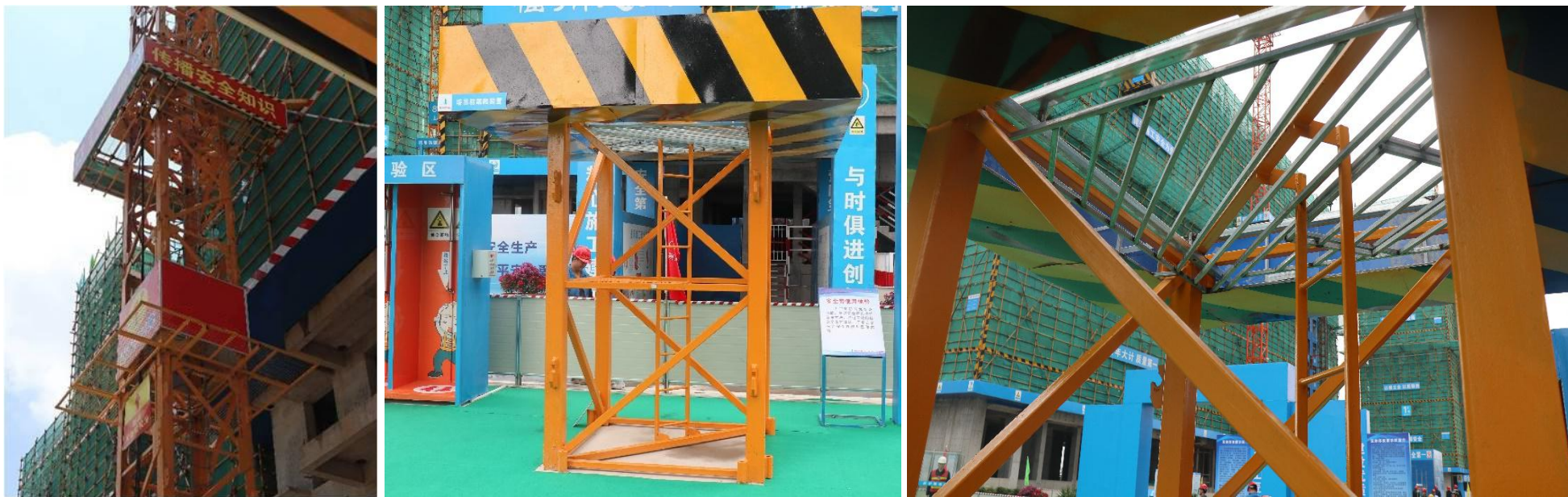
塔吊防攀爬装置图示
