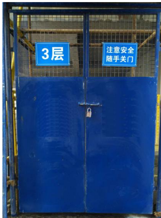
施工电梯防护门图示
