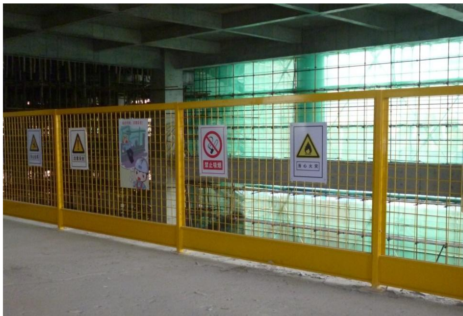
楼层临边防护现场图示1
