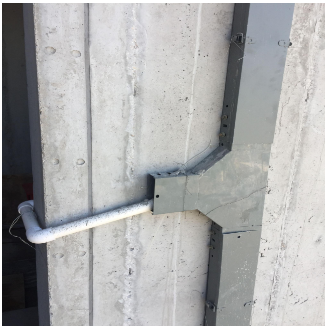
临时用电桥架布置图示
