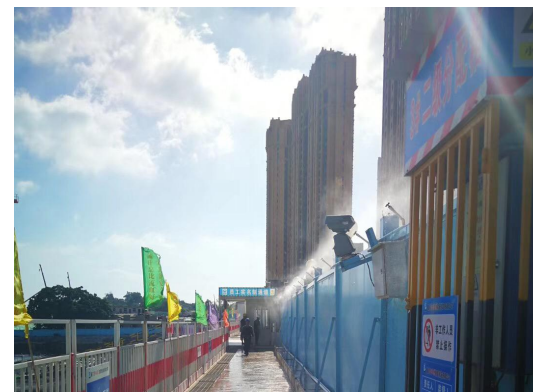
围墙喷淋实景图
